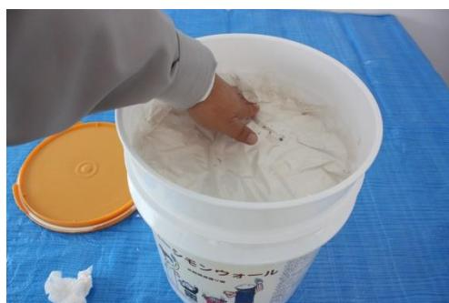
材料を保存する時は、表面を平らにして製品についていたビニールシートを材料の上に隙間なく敷き詰めます。
